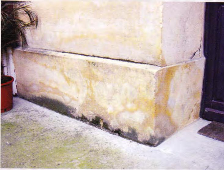
La capillarité, est un phénomène mécanique, qui se produit à la surface d'un liquide en contact avec une paroi solide sous l'effet de la tension superficielle. Le mur absorbe l'eau du sol, lorsque sa base n'en n'est pas isolée. L'humidité du mur entraîne une perte d'énergie, des efflorescences et moisissures, et le décollement des enduits. l'insalubrité des locaux est vite atteinte.
