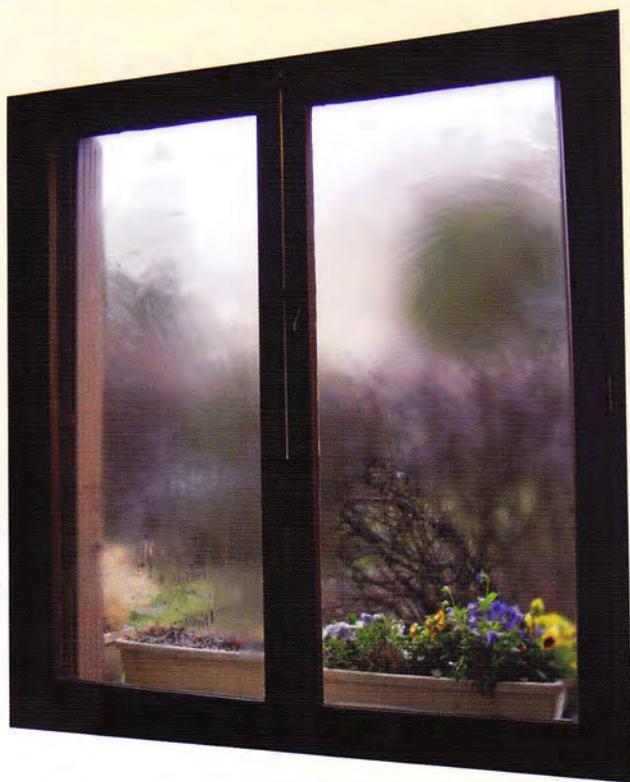
Moisissures, condensation champignons, apparaissent et se développent aux endroits les plus froids ou mal ventilés.
